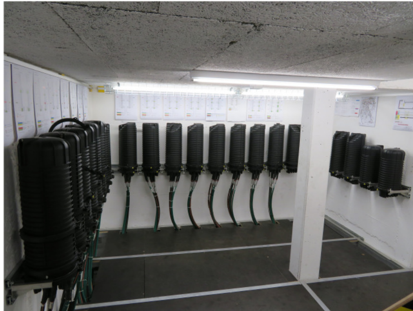
Knotenpunkt Kommunikations-System (POP: Point of Presence)
